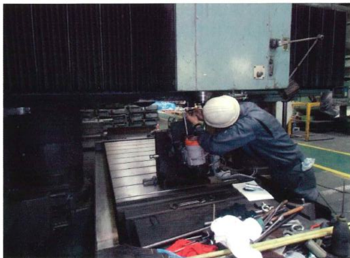
工事前段取り
